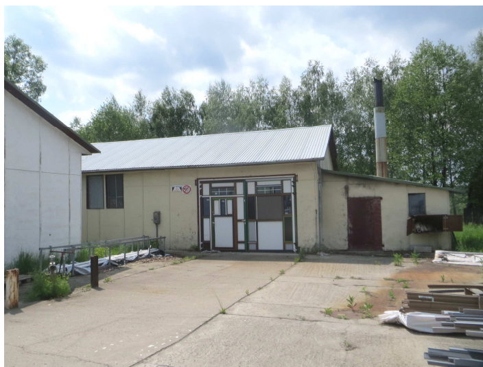
Budynek nr 9 – widok ogólny, wewnątrz
