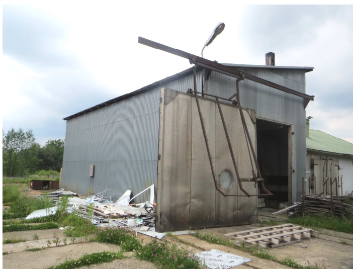
Budynek nr 4 – widok ogólny, wewnątrz
