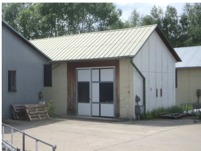
Budynek nr 8 – widok ogólny, wewnątrz
