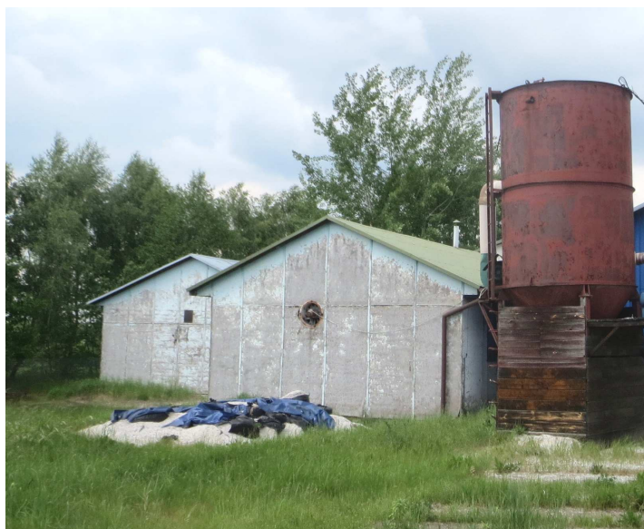
Budynek nr 6 – widok ogólny, wewnątrz
