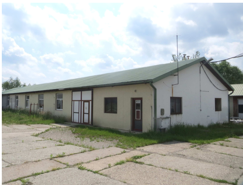
Budynek nr 3 – widok ogólny, wewnątrz
