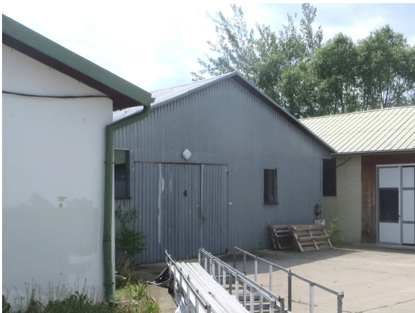
Budynek nr 7 – widok ogólny, wewnątrz
